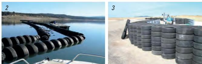
Figura 2 - Sistema per la riduzione dell'altezza delle onde.
