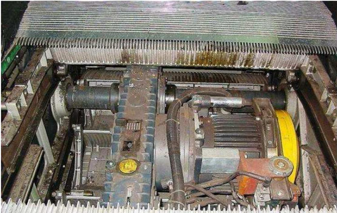
Figura 33 Detalle motor reductor Transvario Kone RTV
