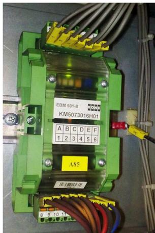
Figura 39 Dispositivo freno A85
